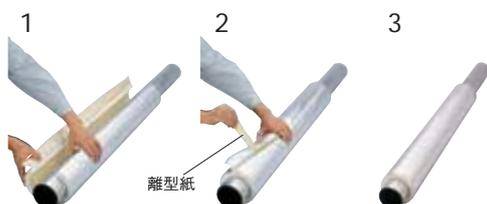
1 軽量ステンレスパイプ専用断熱材を広げて取り付けます。カッターナイフで簡単に切断できます。
