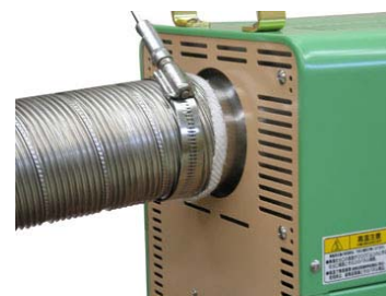
エア漏れ防止用ガラステープ施工例
